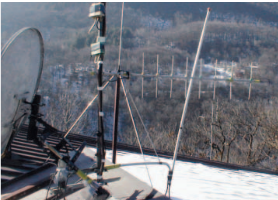
figura 1: sequenza di montaggio della collinere a 900 MHz
