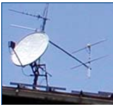
foto 2: Yagi 2 elementi puntata verso il cielo
